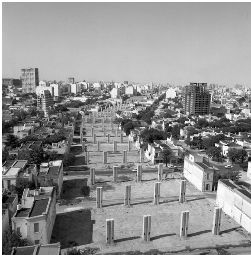
Figura N° 3: Construcción de la Autopista 25 de Mayo, año 1978
