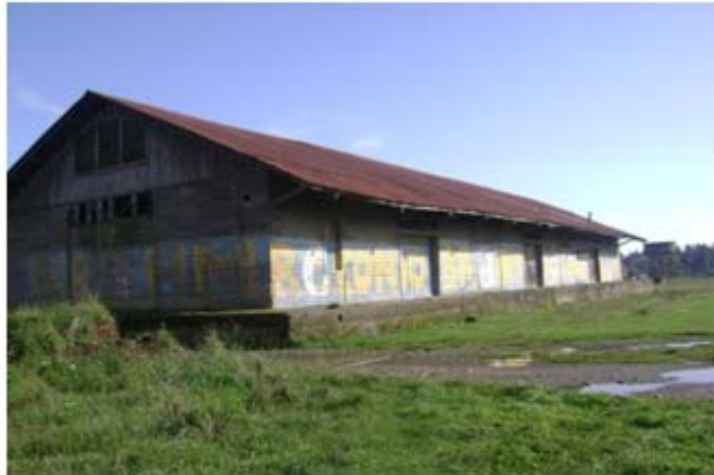
Bodega de Madera Estación Corte Alto
