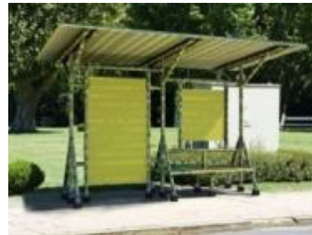
Figura 5: Parada de colectivos en Tigre, realizada en cañas de bambú.
