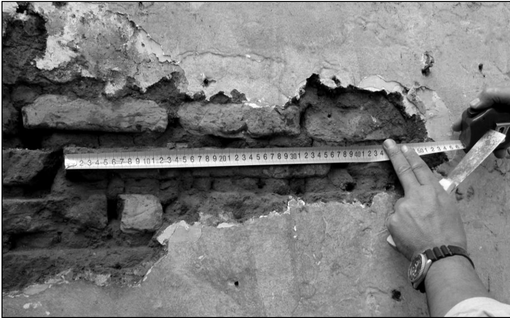
Figura 6. Detalle de la pared lateral sur, en el sector A2, donde puede observarse la presencia de adobes y ladrillos, y las sucesivas capas de cal y pintura
