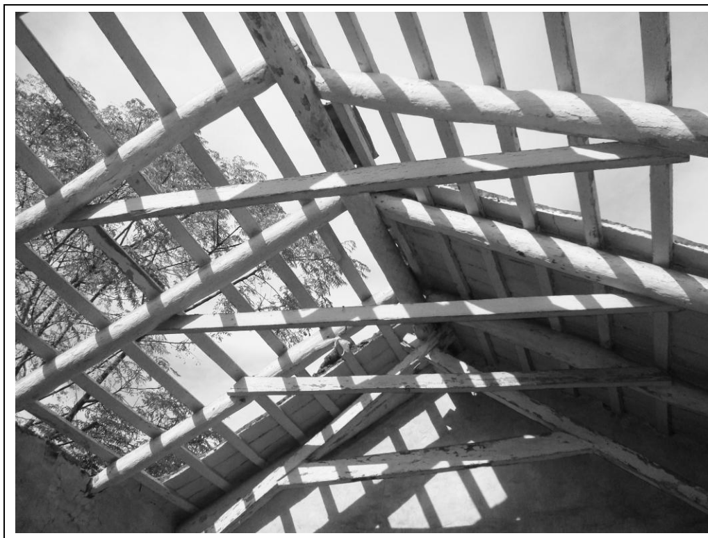
Figura 7. Vista del techo en proceso de desarme, desde el interior de la habitación A
