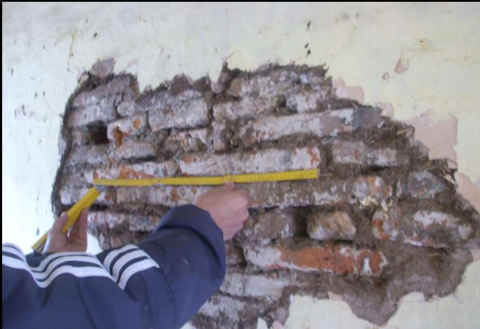
Ladrillos en una de las paredes del sitio La Elvira. El mortero es de barro, no contiene cemento.
