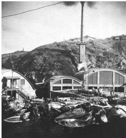
Figura 2. Galpones dentro de la INDUS. Los pescadores de esta caleta manifiestan un gran desapego a la Compañía Industrial, el cual se hace evidente al ver que éstos cuando se enfrentan a imágenes de la ballenera, las explican a grandes rasgos y luego pasan a la siguiente foto.
