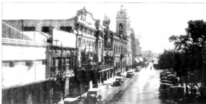
Vista de calle Mendoza antes del sismo de 1944
