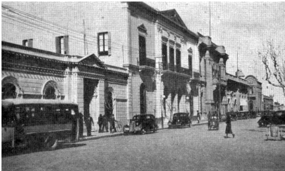
Calle Gral. Acha antes del sismo de 1944
