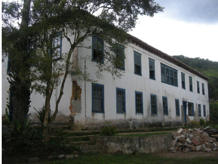
Figura 14: El Caserón de la Hacienda Penedo antes de la restauración Fuente: Foto del autor, 2009
