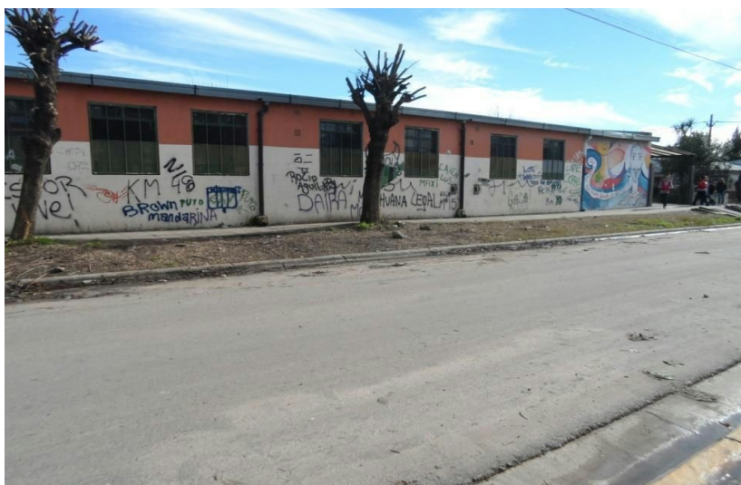
Fachada de la Escuela Media N° 15
