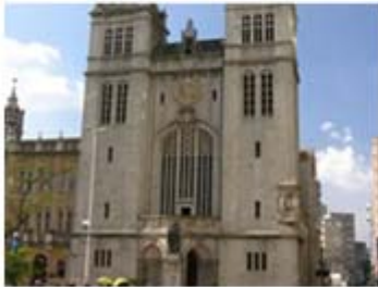
Figura 11: Mosteiro São Bento
