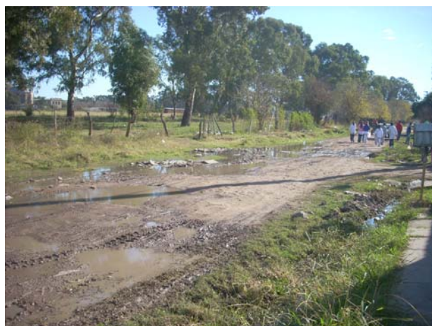
Imagen n° 2: Calles anegadas por lluvias. Barrio “El Plateado”. tomada por la autora el 4 de junio
