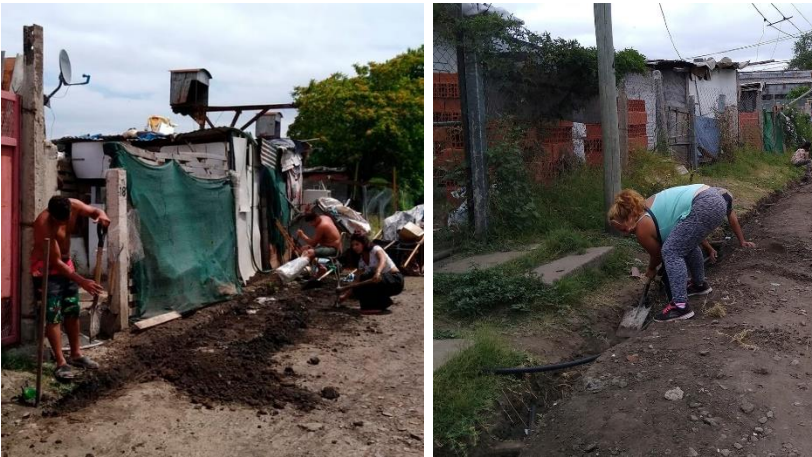
Figura 10. Realización de la red de agua
