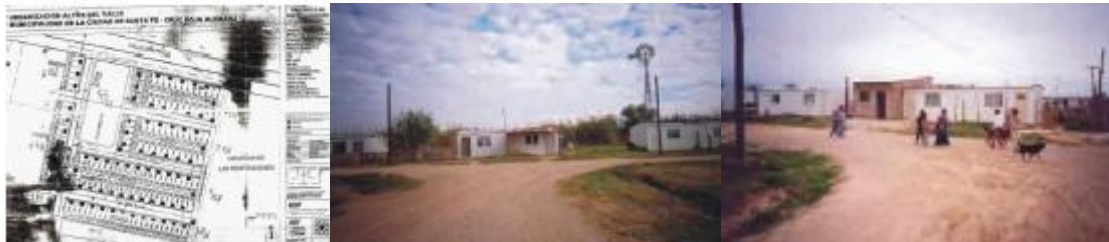
Fotos 01 | Relocalización 29 de abril III (Fuente Propia)
