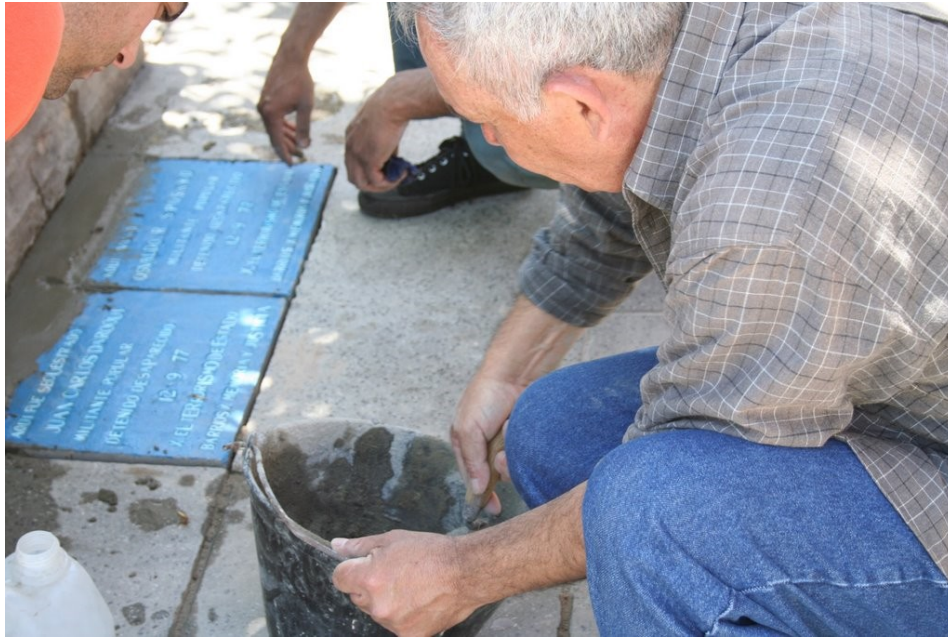
Fotografía del momento de la colocación de las baldosas
