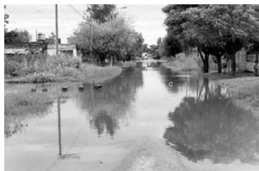
Foto 5: Barrio Los Olmos tras las lluvias.
