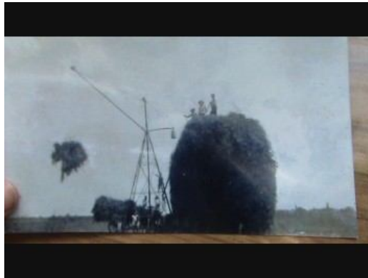
Imagen 2: Guinche para levantar la alfalfa inventado por el padre de uno de los entrevistados. Fotografía del año 1932.
