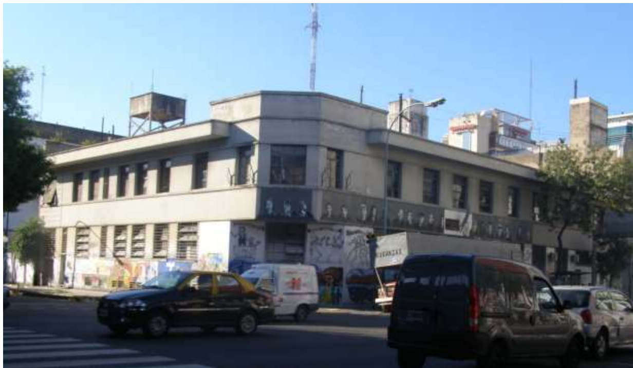
Fotografía 1. Frente de la escuela donde se ve el friso.
