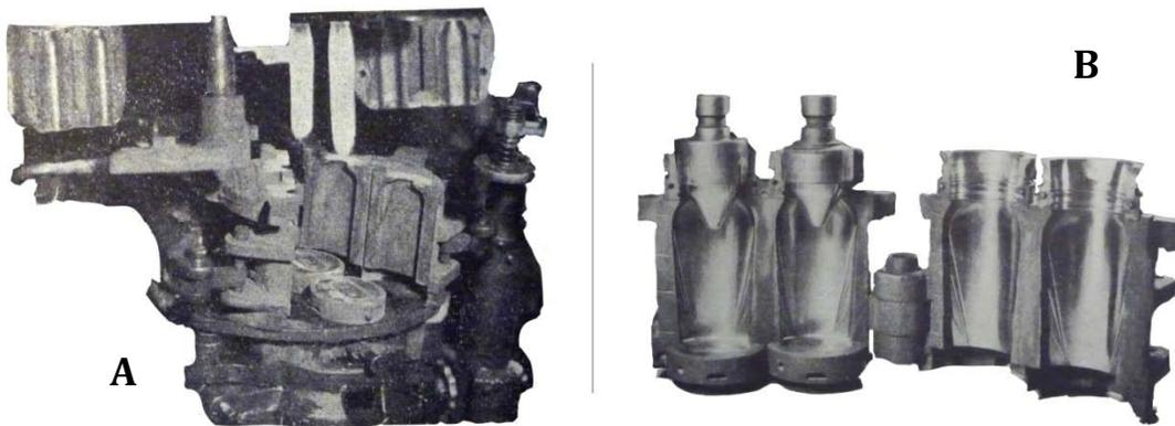
**Figura 17.** A: máquina Owens, transferencia del *parison* (suspendido) al molde de soplado; B: moldes *parison* (tomado de Tooley 1953)
