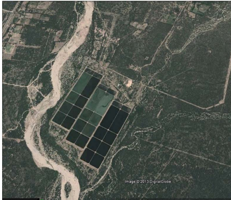
Figura 1. Sistema de lagunas de estabilización. Ciudad Capital de Catamarca
