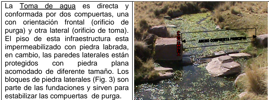
Figura 3. Vista frontal de la Fuente y Toma de agua. Amplitud del orificio de purga. 2.010.
