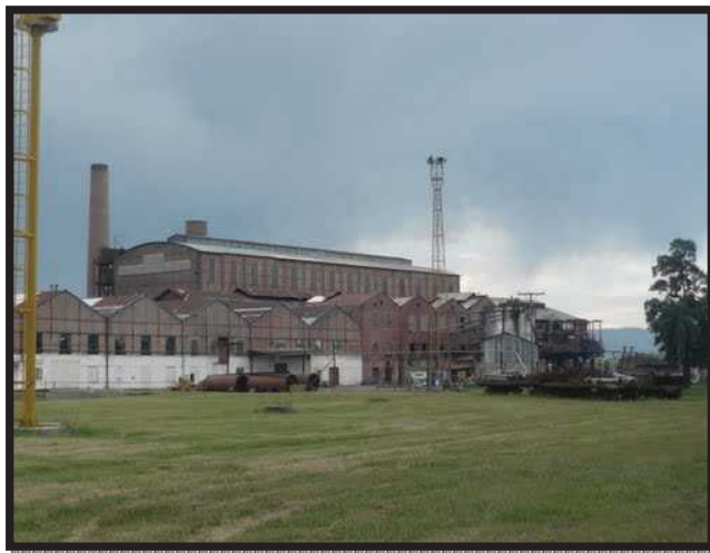
Figura 36: Vista del Ingenio Bella Vista Fte.: Panoramio (2010).
