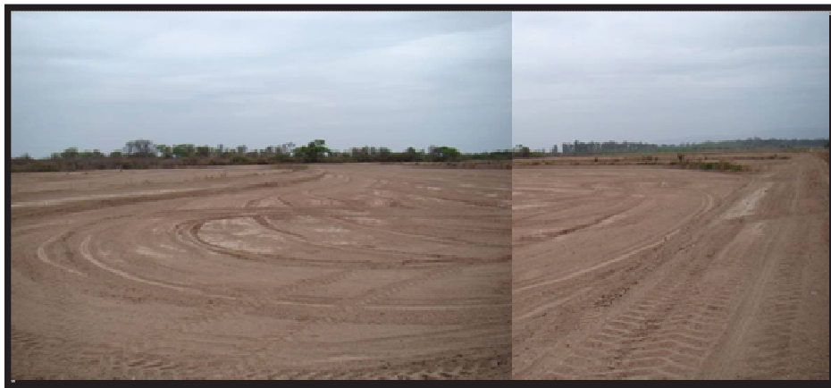
Figura 22: Piletas de evaporación del Ingenio Ledesma. Fte: Ledesma S.A.A.I.
