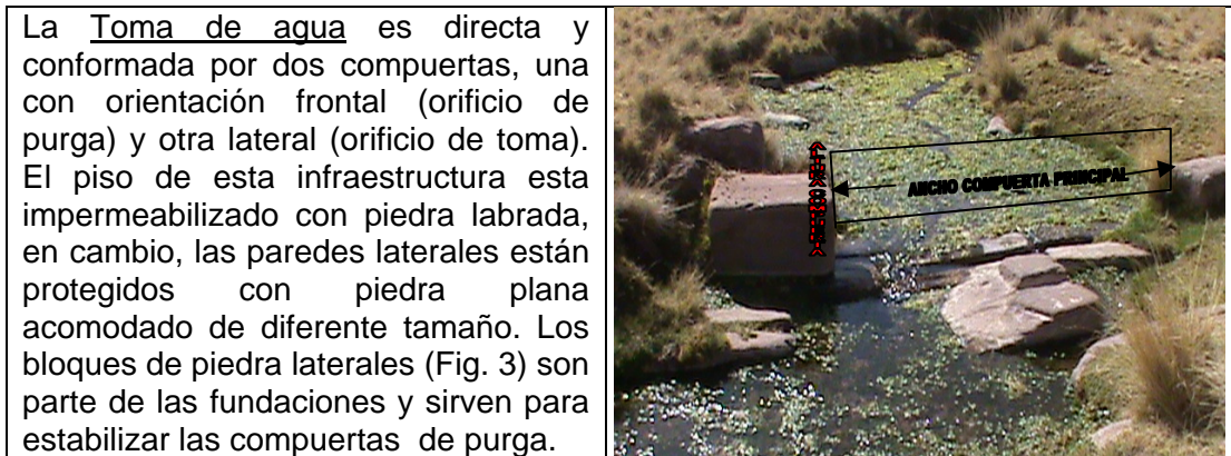
Figura 3. Vista frontal de la Fuente y Toma de agua. Amplitud del orificio de purga. 2.010.
