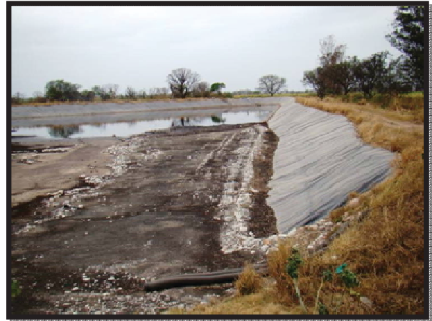
Figura 24: Piletas de evaporación
