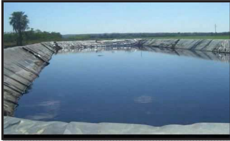
Figura 39: Foto de la pileta de evaporación en el Ingenio El Tabacal. Fte: Eco Sitio (2012).
