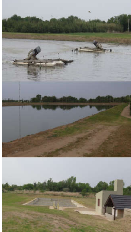
Figura 73. Parche PTELC. Planta de Tratamiento de Efluentes Líquidos Cloacales.
