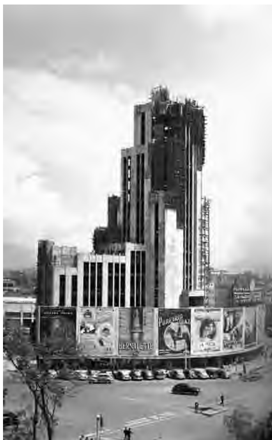
Anuncios cinematográficos en el edificio de la Lotería Nacional en construcción, Juan Guzmán, Ciudad de México, ca. 1944 (Colección Fundación Televisa).
