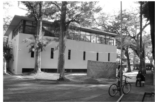
Figura 6: Vista sudeste del edificio
