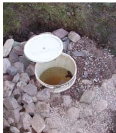
Captación de un manantial realizada con un balde de 20 litros perforado en los laterales, y enterrado. Se observa además la salida a la conducción, también se lo rellena con ripio para mejorar la captación. Maimará.
