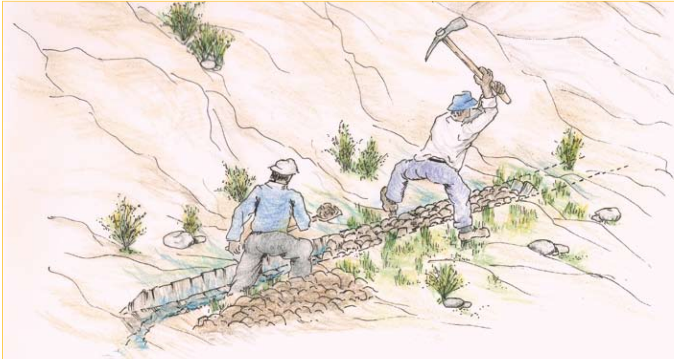
Excavación de la zanja en forma transversal a la pendiente.
