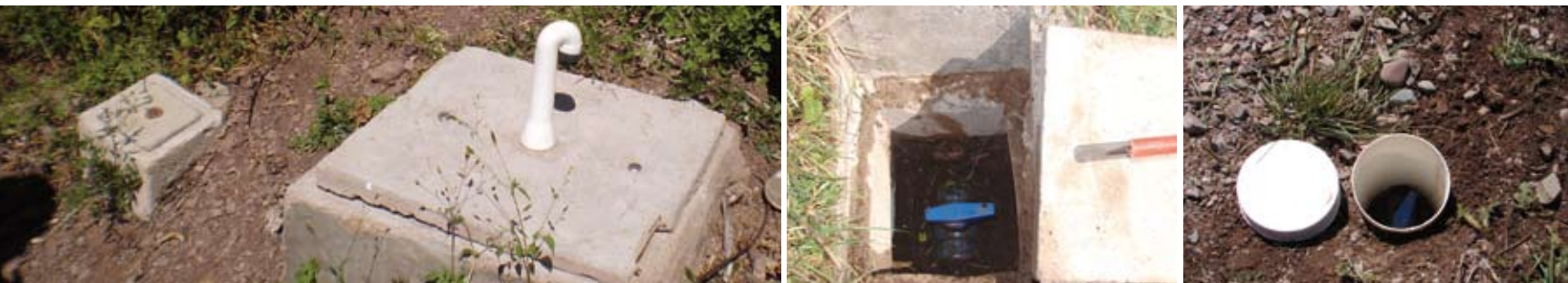
Cámara de carga y cámara seca. Cámara seca de mampostería y cámara de PVC.
