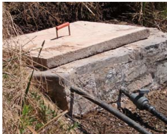
Terminación de la captación.
