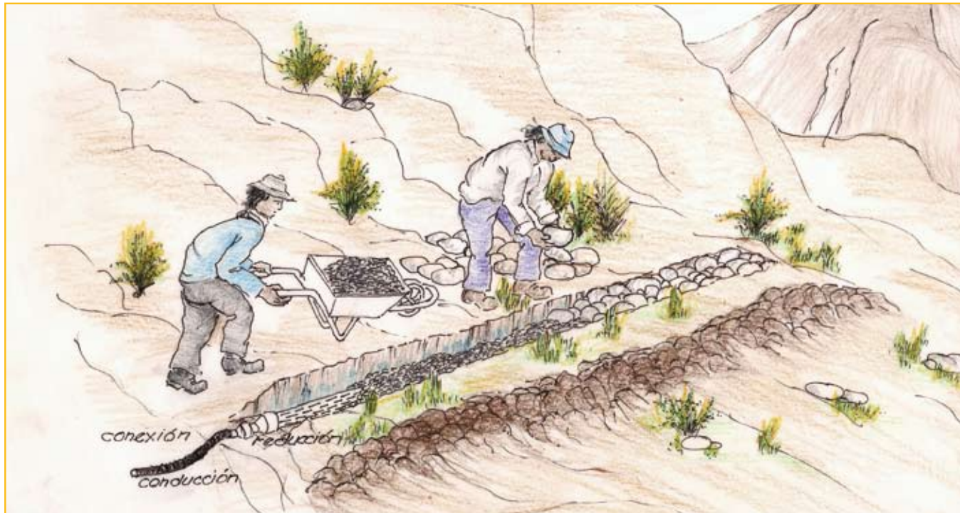
Tapado con ripio y piedra para la terminación de la captación en manantial difuso de ladera.
