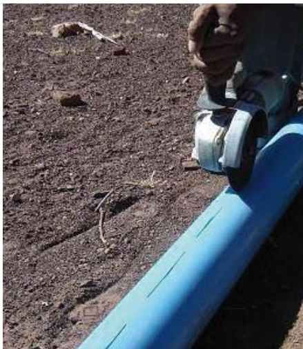
Ranurado del caño con amoladora. Comunidad La Laguna Brealito. Salta
