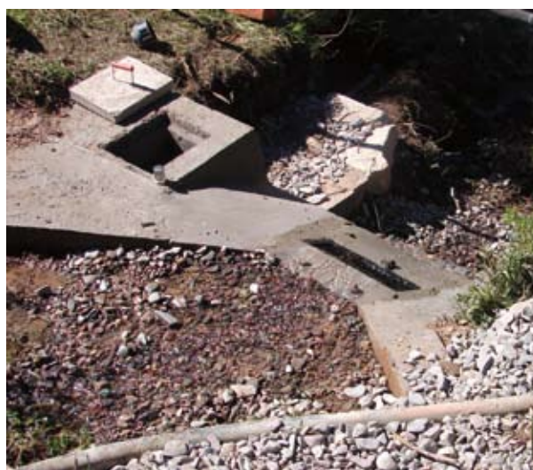
Captaciones mediante toma rejilla. Los Corderos Catamarca y Maimará Jujuy.
