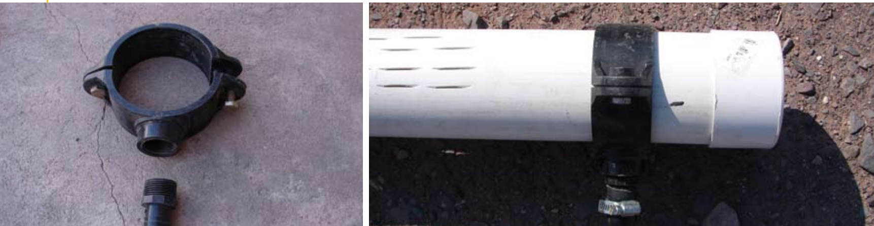
Conexión mediante abrazadera de derivación.
