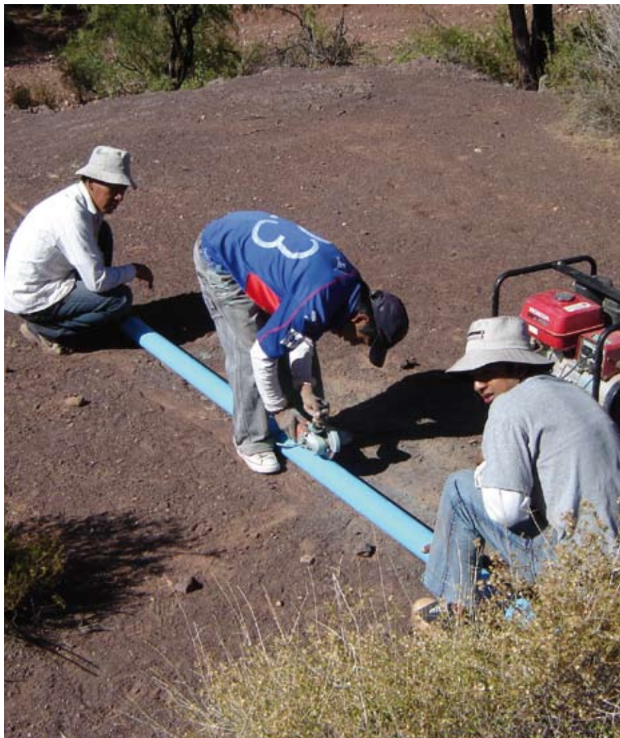
Ranurado del caño con amoladora. Comunidad La Laguna Brealito. Salta
