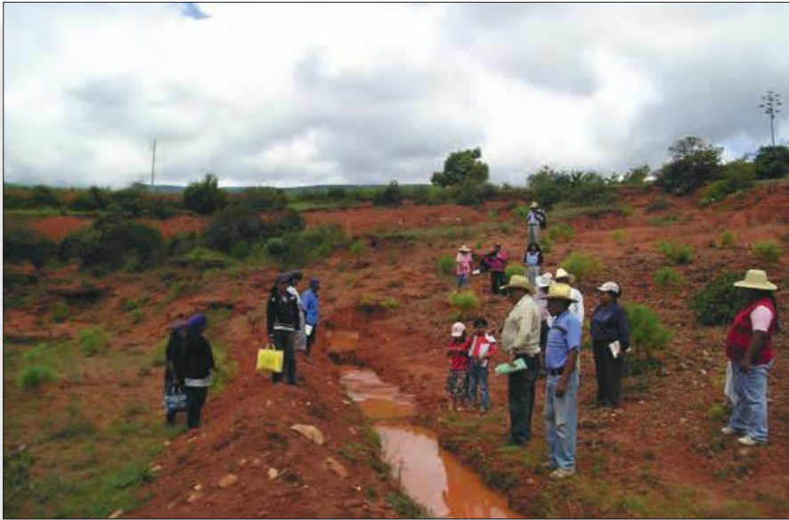
Zanja trinchera. Comunidad de Buena Vista Tilantongo
