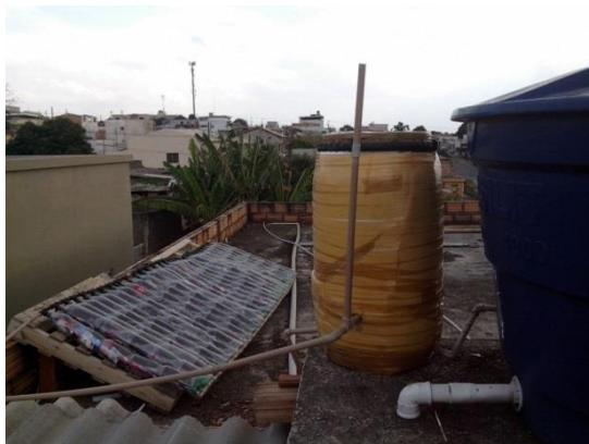
Figura 02 – Aquecedor Solar implantado. Fonte: Acervo Pessoal
