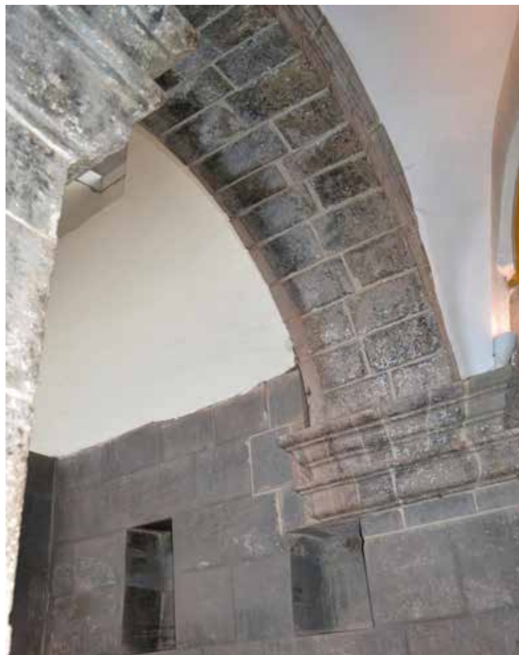
▲ Arco sobre arco Claustro de San Agustín Tunja Fotografía: Pilar Jovanna Holguín. 2015
