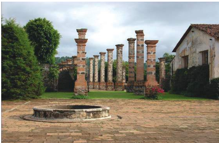
Antigos silos e galpões para guardar os produtos agrícolas produzidos.
