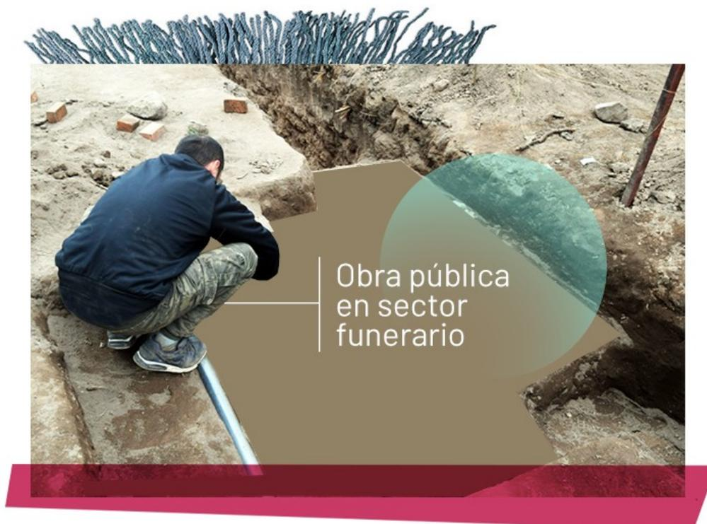
Trabajos de rescate arqueológico en la zanja abierta para el paso del gasoducto troncal. También se observa el caño de agua instalado en la década de 1990, en un trazado paralelo al gasoducto.
