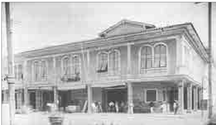
Foto 3. Almacén de Juan Kruger
