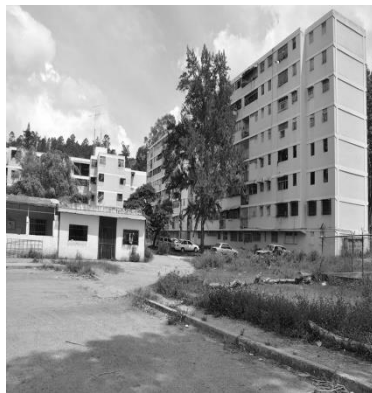
SECTOR "D y E", BLOQUES 7,8,9
