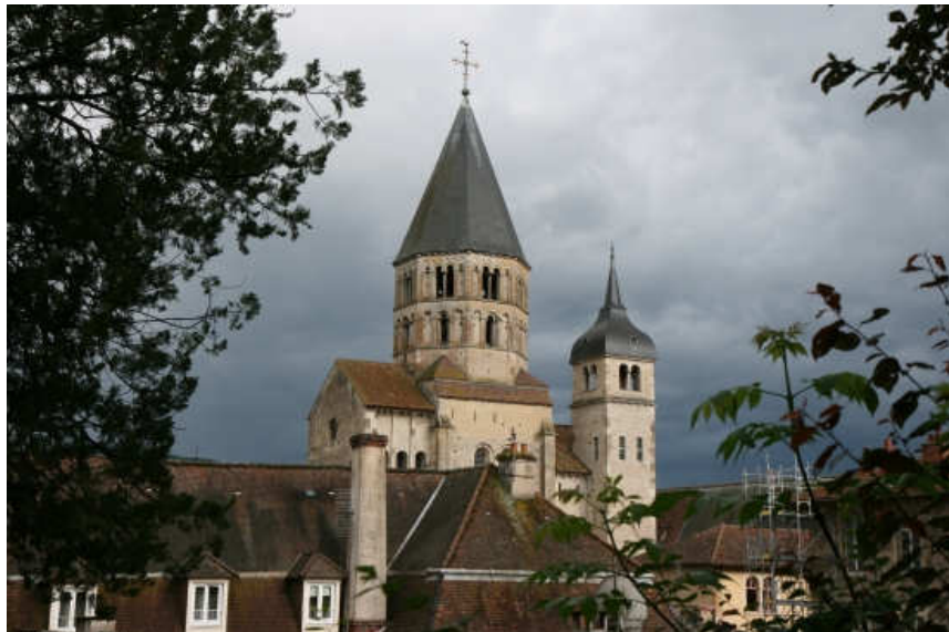
Cluny – Estado actual de los restos del edificio
