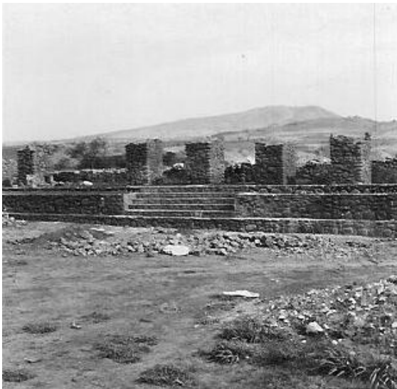
Foto 29- Trabajos en Edificio Escuadra Ixtlán del Río, Nayarit - 1967
