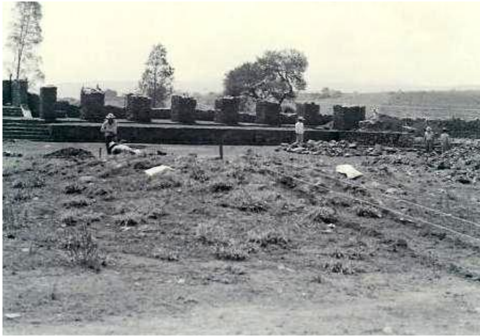
Foto 28.- Trabajos en Edificio Escuadra Ixtlán del Río, Nayarit - 1967
