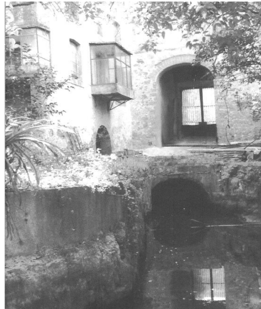
Fig. 15 Canalización para el Molino de Sta Mónica (López Mora,2002:Portada)
