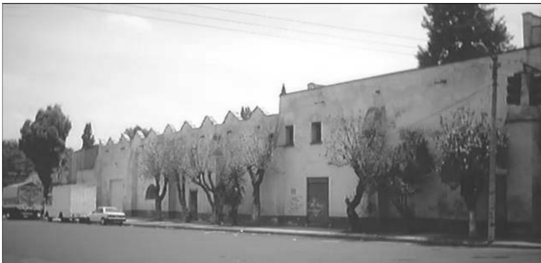
Fig. 9 Vista exterior del casco de la hacienda-rancho de Acalotenco (Donde hasta 1975 existían las trojes anexas en su lado Norte)
