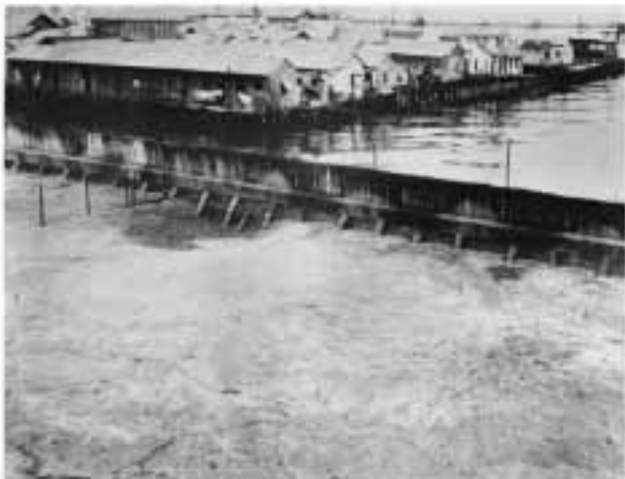
Estacada de madera que servía de muro de contención: Lagunillas de Agua (1927)
