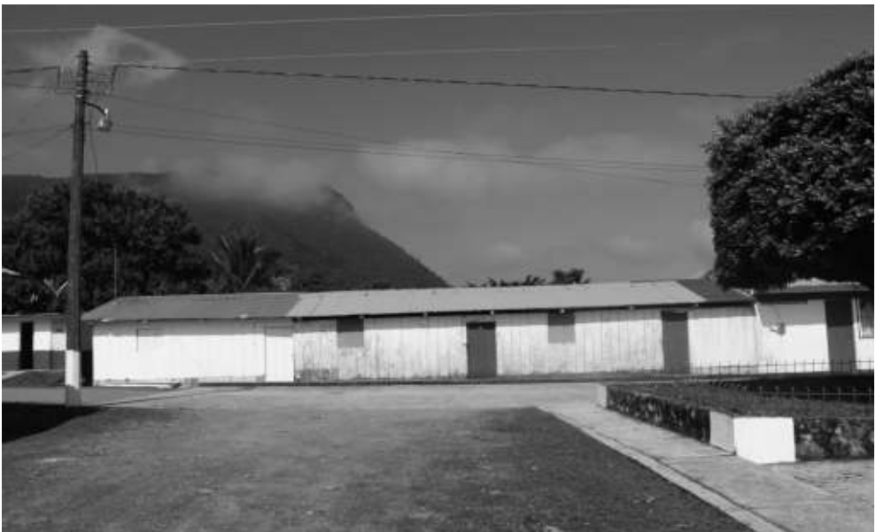
Fotografía 12. Casa ejidal con paredes de madera y techo de lámina. Año 2015.
