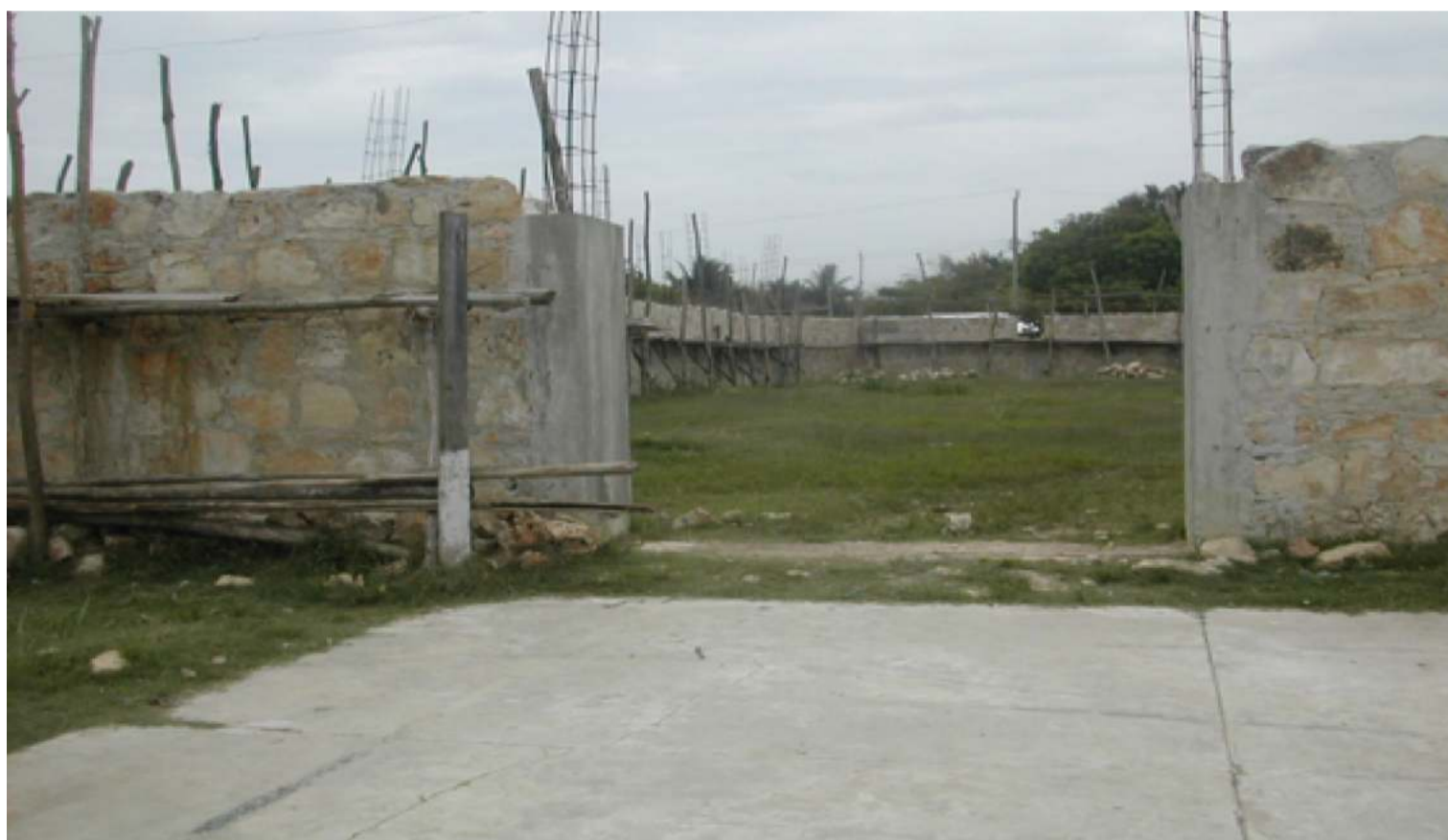
Construcción de la nueva iglesia de Nuevo Francisco León 21 , municipio de Ocosingo.
