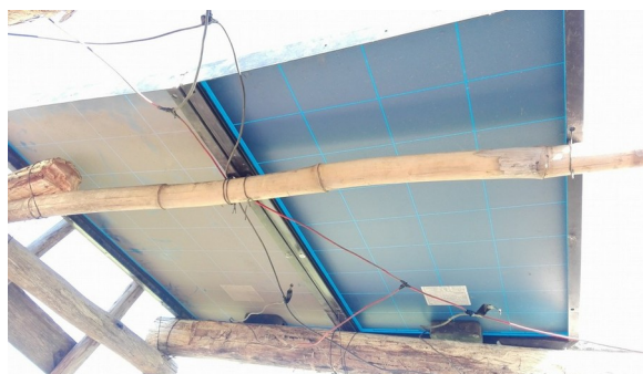
Figura 9. Foto dos painéis usados vistos por dentro do galpão. Fonte: próprio autor
