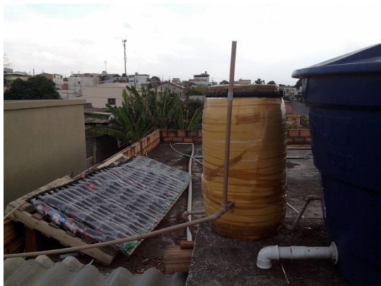
Figura 02 – Aquecedor Solar implantado. Fonte: Acervo Pessoal
