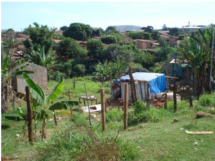
Figura 4: Habitação em uma área de risco, próxima ao Córrego Vertente Grande, no bairro Vila Esperança. Fonte: CUNHA Em: 27/05/2010.
