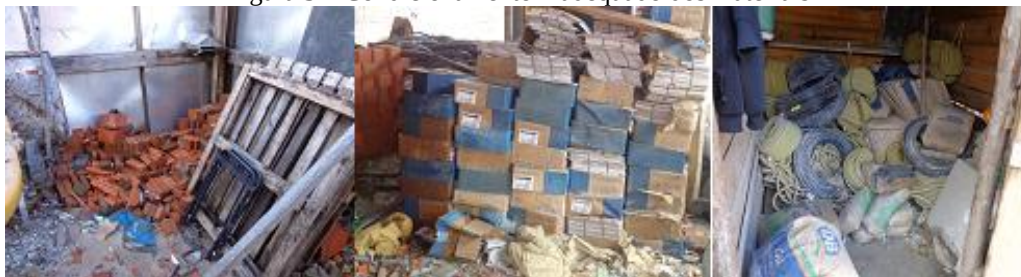
Figura 5 – Condicionamento inadequado dos materiais
