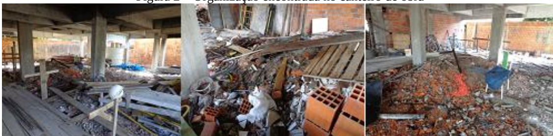
Figura 2 – Organização encontrada no canteiro de obra
