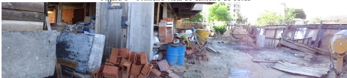
Figura 1 – Primeira vista do canteiro de obras
