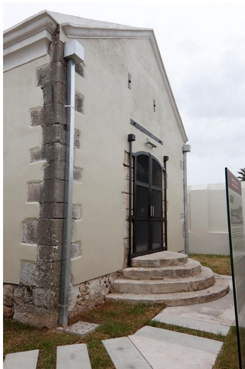
Figura 27. Entrada al edificio del Almacén de la Pólvora, restaurada. Año 2021. Fuente: Archivo de los autores.
