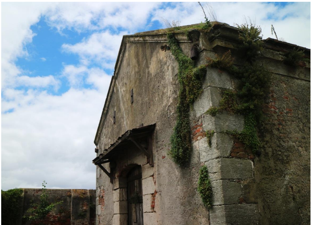
Figura 9. Parte superior de la entrada al Almacén. Año 2019. Fuente: Archivo de los autores.
