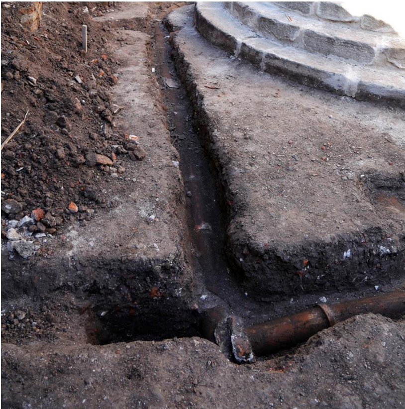
Figura 22. Hallazgo de cisterna y canalizaciones de gres en el marco de los cateos. Año 2019. Fuente: Archivo de los autores.
