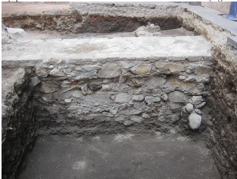
Figura 12. Detalle de la trabe en el perfil norte del Pozo 1.
