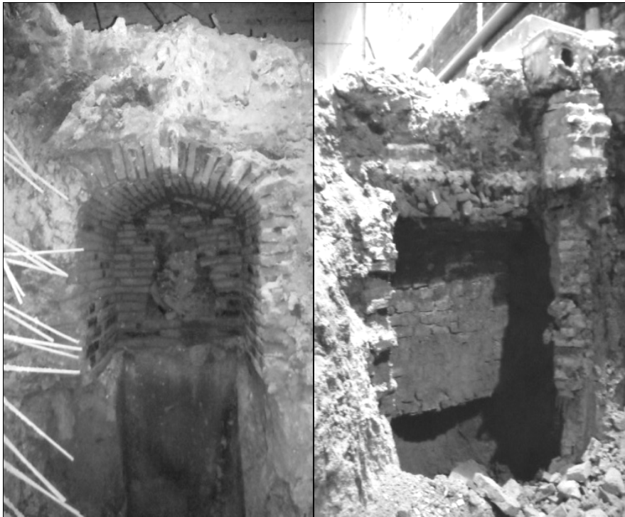
Figura 7. a-Antigua estructura del siglo XIX (izquierda); b-El pozo de desechos (derecha).
