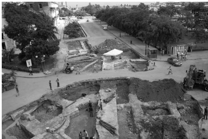
Figura 3. Excavación arqueológica realizada en uno de los tramos de la muralla marítima de La Habana Vieja, realizadas por el Gabinete de Arqueología
