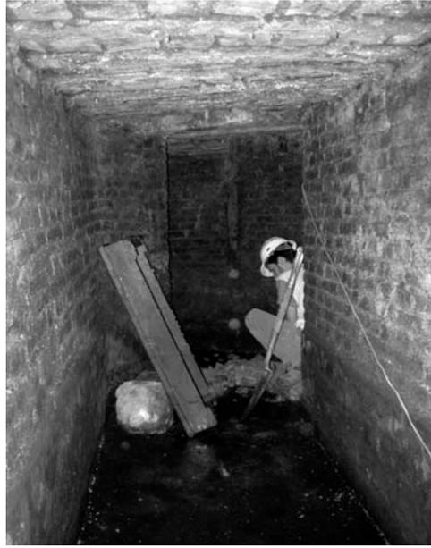
Figura 7. Galería de acceso bajo el edificio A, con piso y muros revestidos en la parte inferior.
