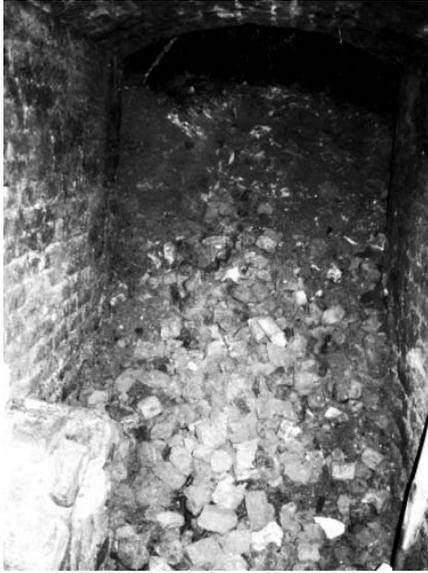
Figura 4. Taponamiento de ladrillos arrojados desde un agujero en la bóveda del túnel, a partir de ese sitio todo estaba cancelado
