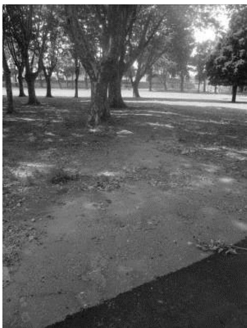
Figura 9. Resto de otro camino interno.
