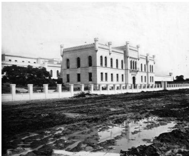
Figura 1. Previo a su adoquinado las calles de Buenos Aires se presentaban de tránsito dificultoso luego de las lluvias.
