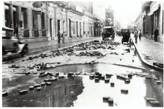
Figura 6. Adoquines de Madera. En muchos casos cuando llovía fuerte, éstos terminaban levantándose y anegando las calles.
