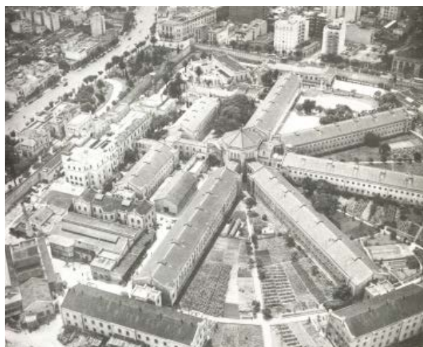
Figura 5. Fotografía aérea de la Penitenciaría Nacional, donde pueden observarse la entrada principal, la casa de guardia, el centro de observación, los cinco pabellones y los edificios destinados a los talleres, así como las huertas y jardines interiores. Fuente: Secreta Buenos Aires. Palermo, el apellido de un barrio de cuchilleros (22/11/2011, fig. íconos. La antigua cárcel de Las Heras y Coronel Díaz).
