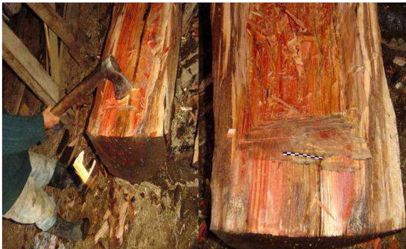
Figura 11. El ahuecamiento del tronco se realiza mediante la técnica de cortes transversales en los extremos y el centro del tronco, para luego extraer longitudinalmente aprovechando las fibras de la madera, la masa que se encuentra entre estos cortes. En la secuencia se aprecia como se va realizando uno de estos cortes transversales con el hacha, y las huellas que van quedando sobre la madera.
